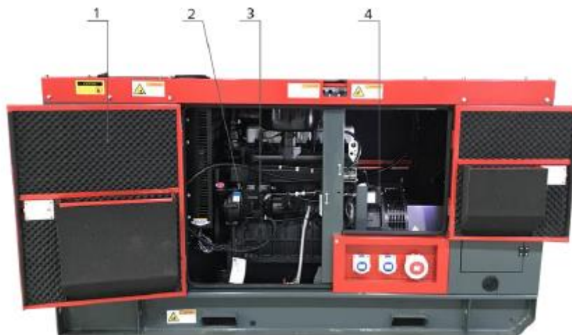
Abbildung 2-3.1 Dieselgenerator Übersicht (Vorderseite offen)
